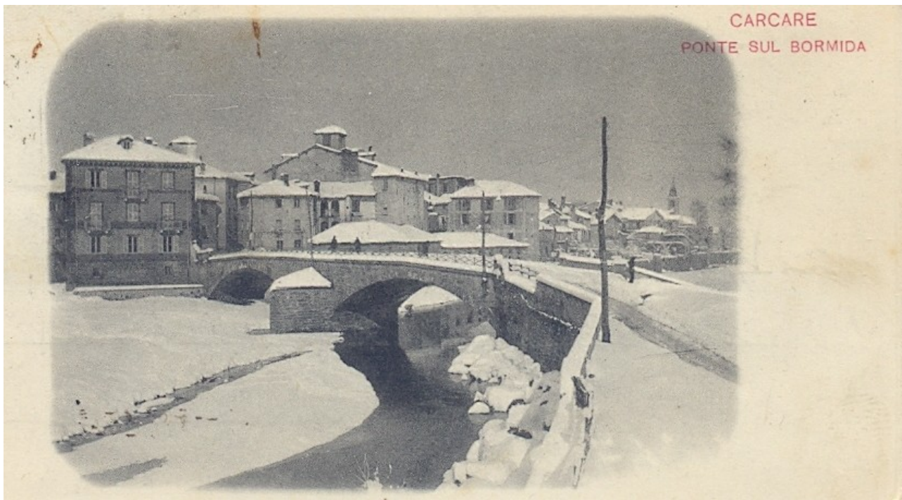
Ponte sul Bormida
